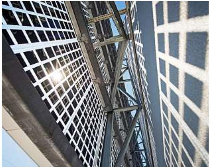
möglicht einen industrieführenden Modulwirkungsgrad und garantiert auch bei sehr hohen Umgebungstemperaturen maximale Energieerträge. Die Stromverbinder zwischen den Zellen sind unsichtbar und ergeben dadurch auf einer Gesamtfläche von 633 m<sup>2</sup> ein äusserst homogenes Erscheinungsbild.
